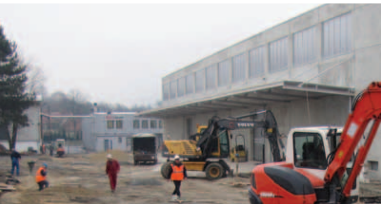
Takto bylo možné vidět stavbu na konci roku 2011...
